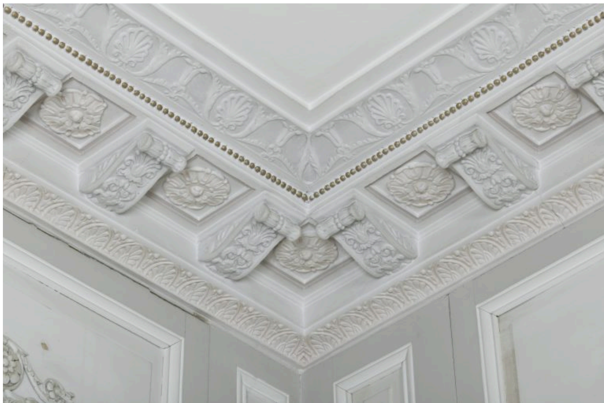
Cabinet du maire, détail du plafond.
