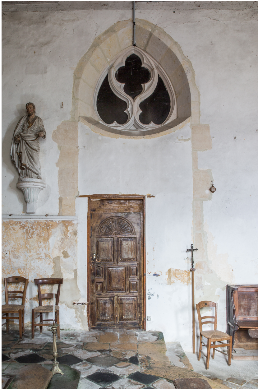
L'ancienne baie et la porte du mur nord du choeur.
