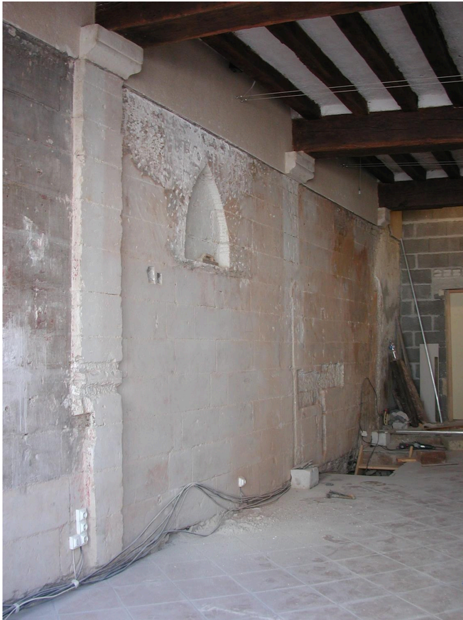
Rez-de-chaussée, boutique : élévation intérieure gauche (est) appareillée en tuffeau, vue en axe nord-sud. Dégagement pendant les travaux de juin-juillet 2001.
