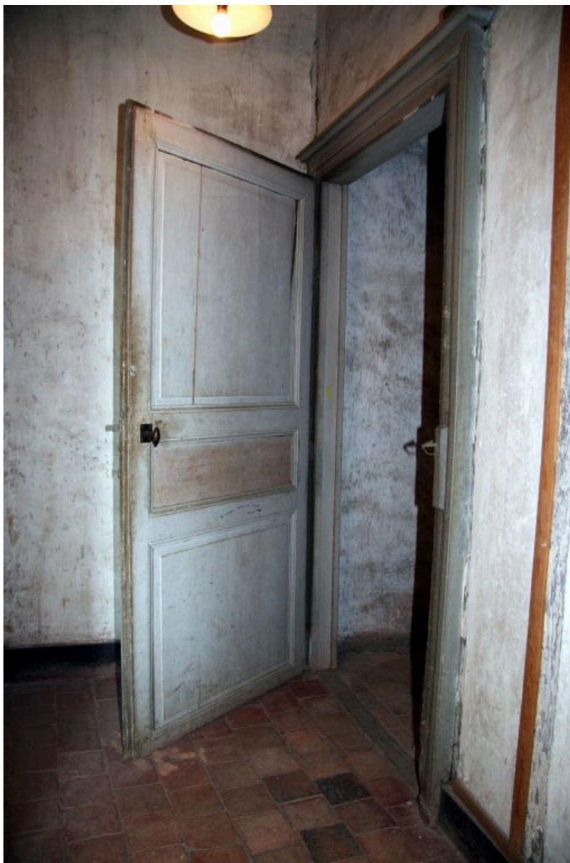
1er étage, au bout du couloir, palier de l'échelle de meunier : porte ouverte.
