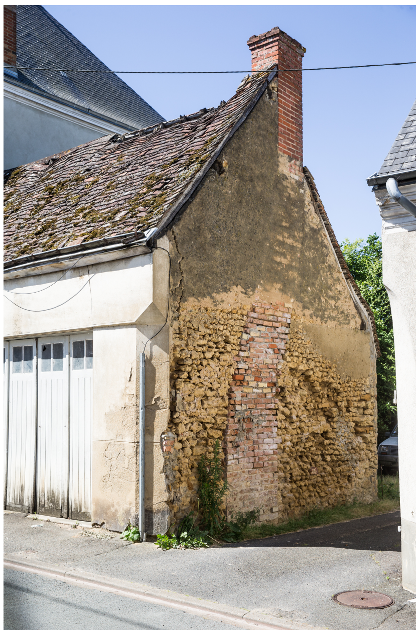
Un ancien logement transformé en garages, rue de la Rochelle.
