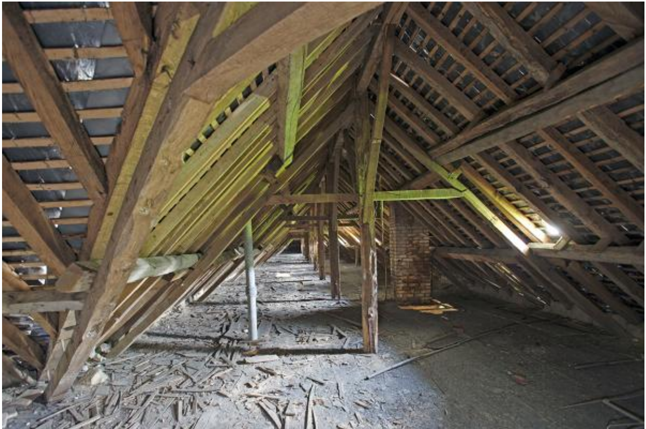
Le corps de commons dit "grange d'abondance", second niveau de comble.
