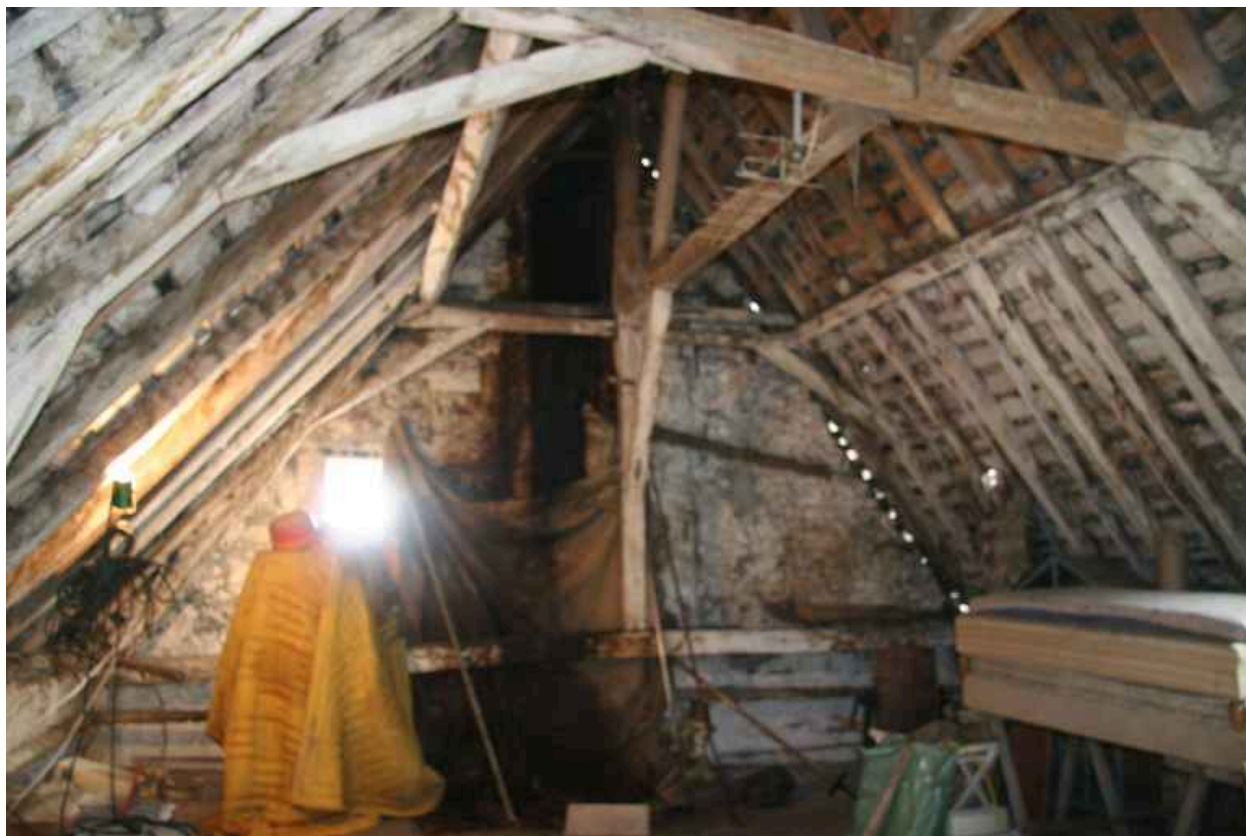
Charpente de la vieille maison : détail.
