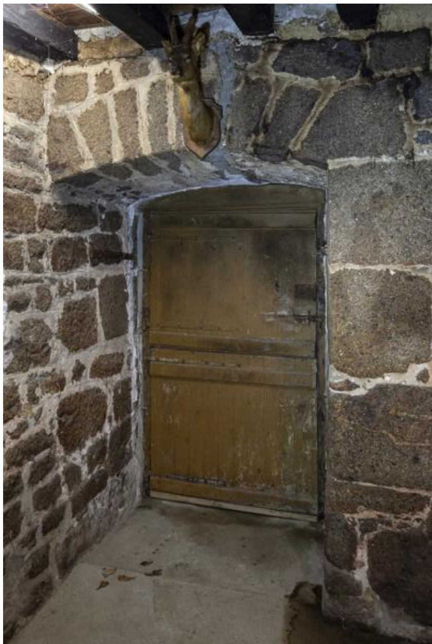
Revers de la porte du mur-pignon oriental.
