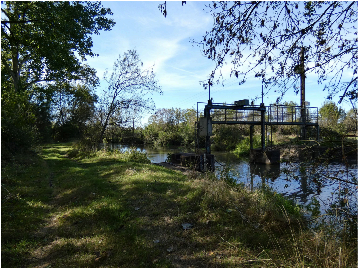
Le barrage sur la Vieille Sèvre, vu depuis l'amont, à l'est.
