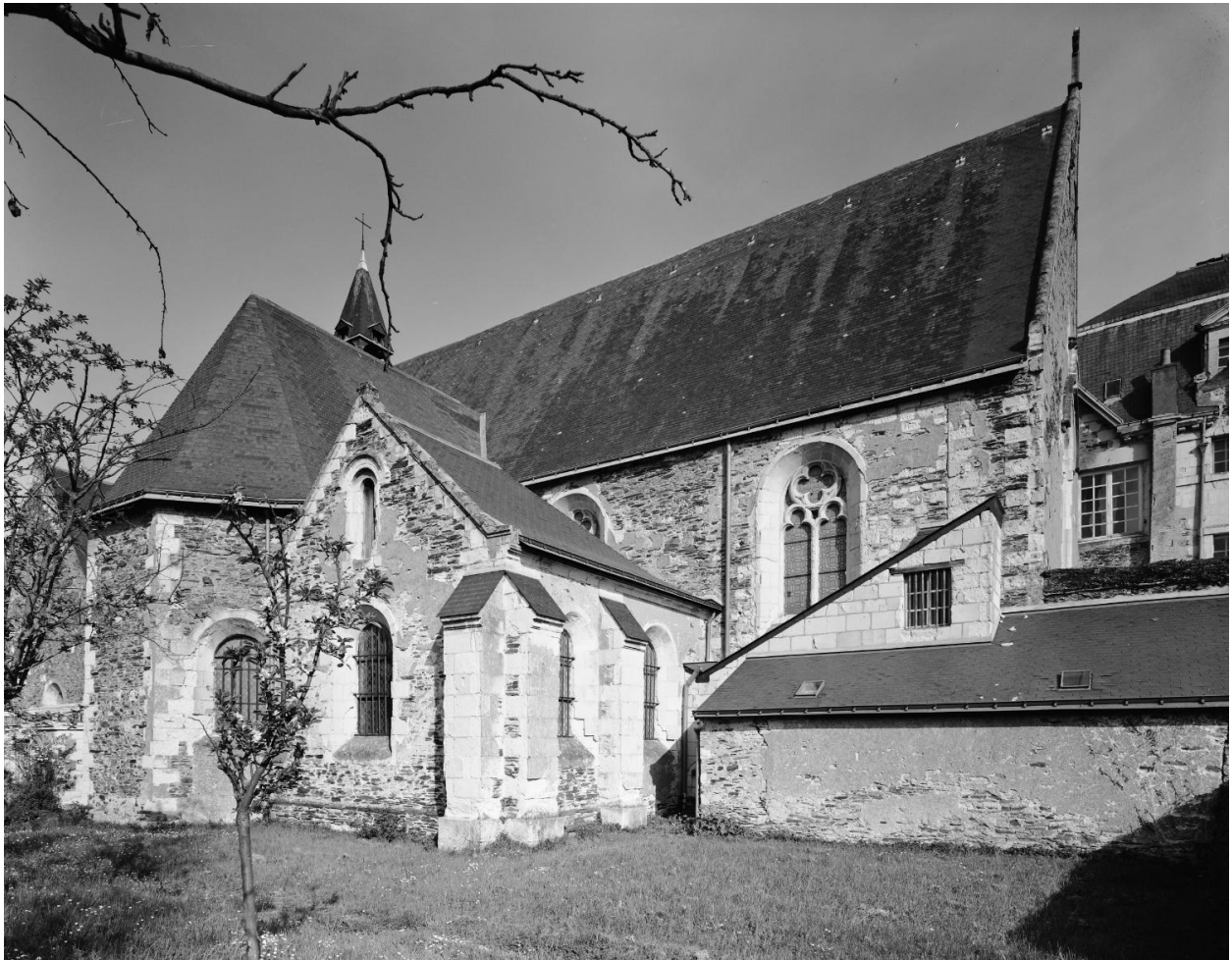
Eglise : élévation latérale gauche, vue de trois quart, à hauteur de la façade occidentale, avec les chapelles au premier plan.
