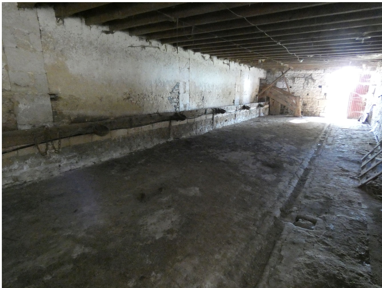
Vue intérieure de l'étable latérale sud.
