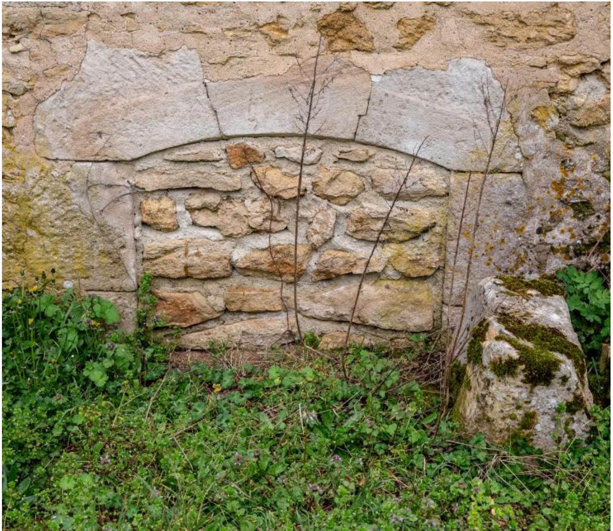
Une porte murée du bâtiment abritant le four.
