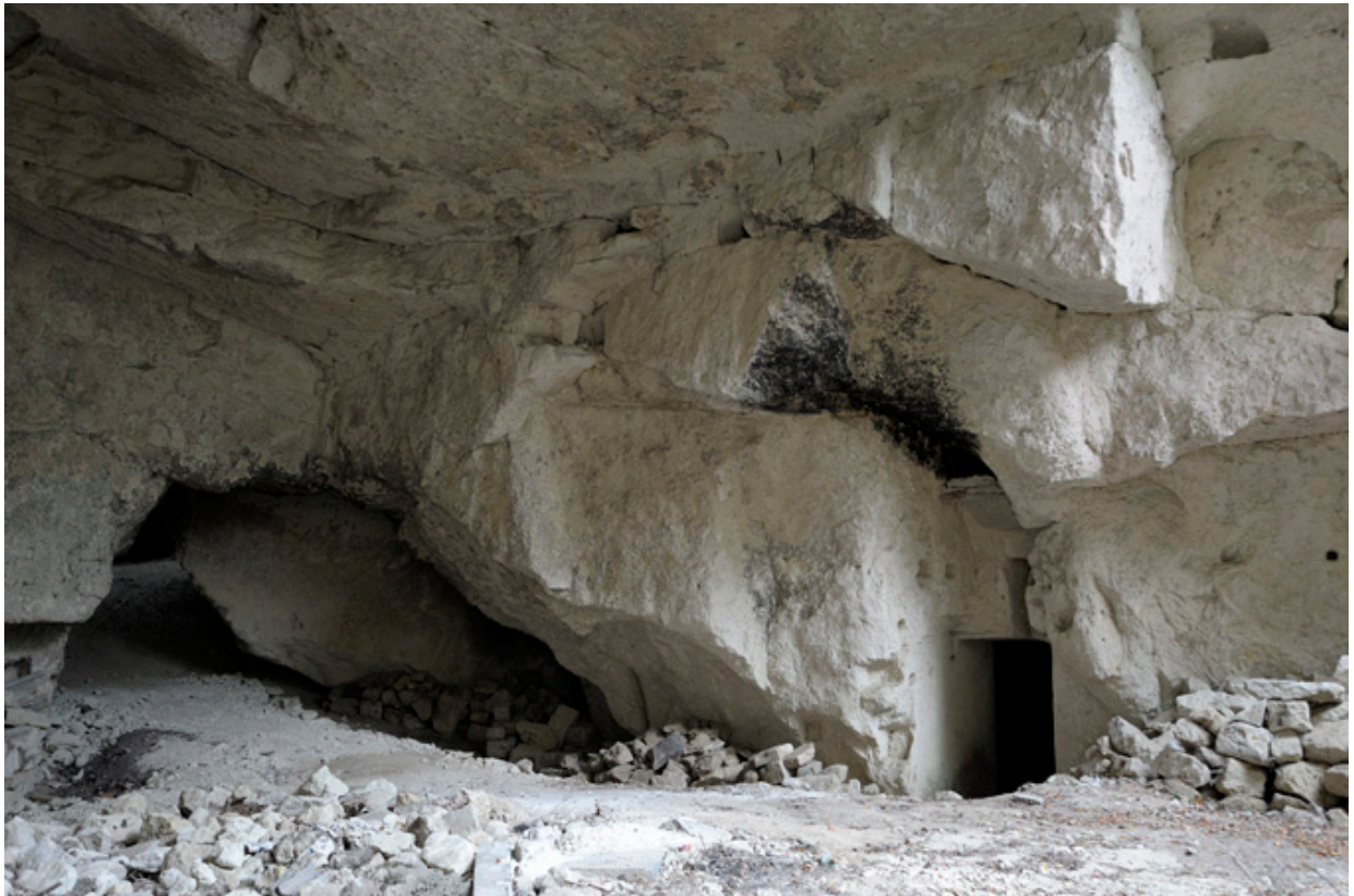
Site principal (11-16, ruelle des Perreyeurs). Fontis est. Abri troglodytique et départ de la galerie d'exploitation..
