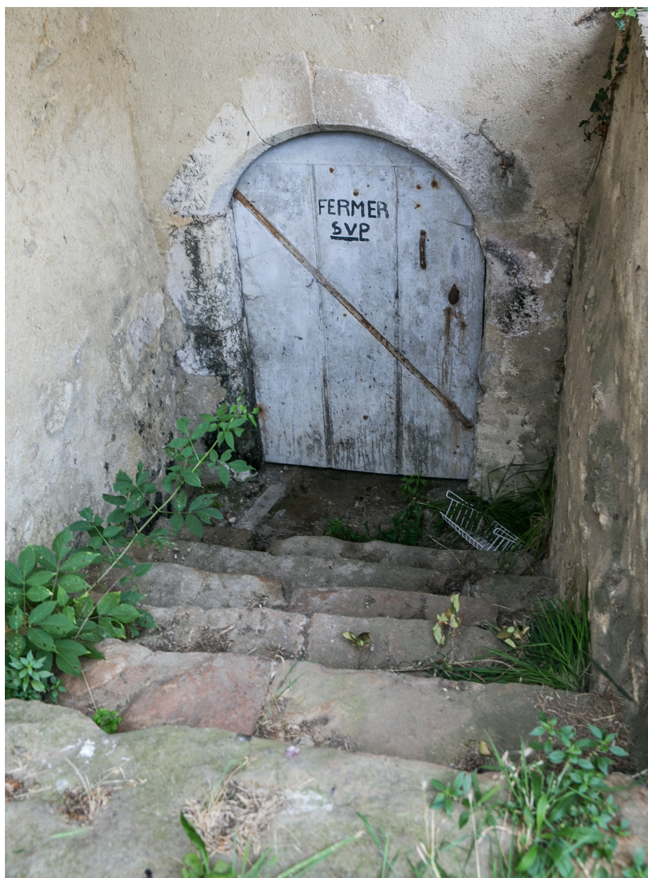
La demeure principale, la porte du sous-sol.
