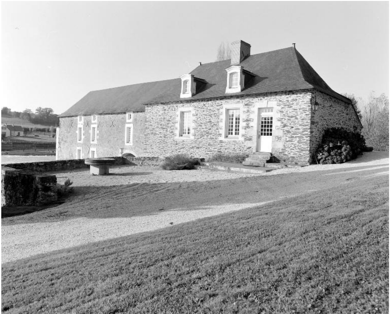
Vue du sud-est : moulin, logement du meunier.
