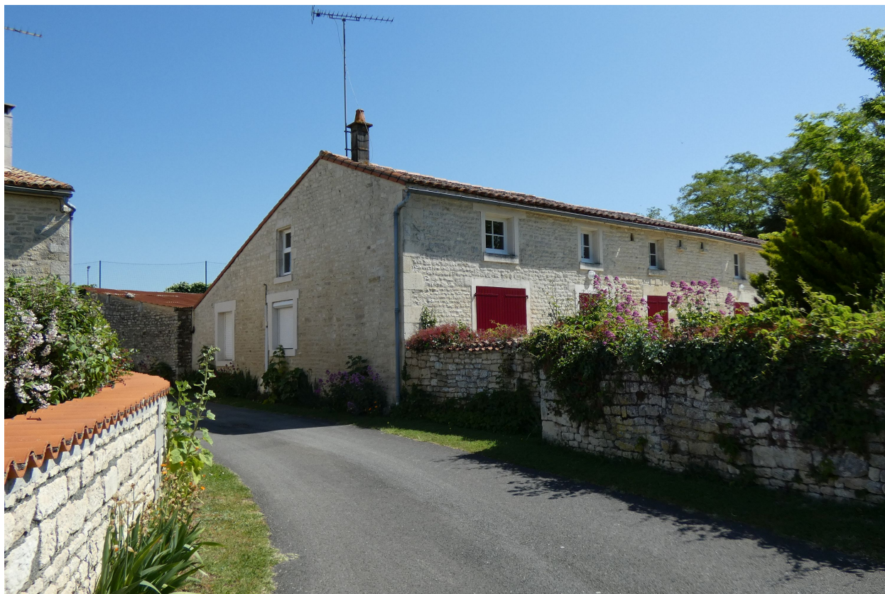
Le logis vu depuis le sud-ouest.
