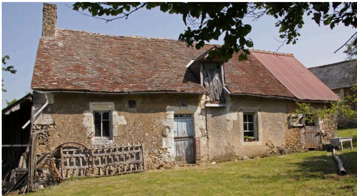
Maison 1 : façade antérieure (sud).
