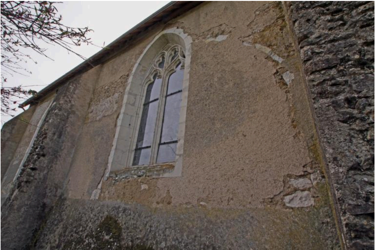
Chœur, façade nord, détail : traces d'une baie murée et d'une litre.
