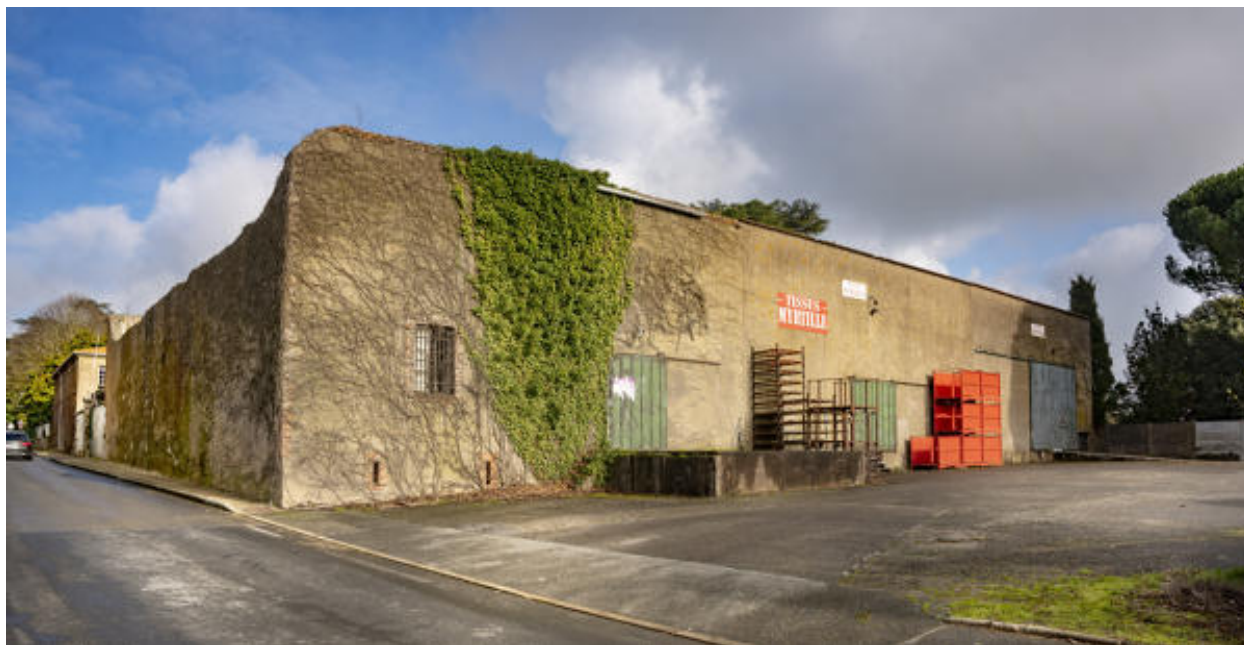
Bâtiment de stockage et quais de déchargement, vue du sud.
