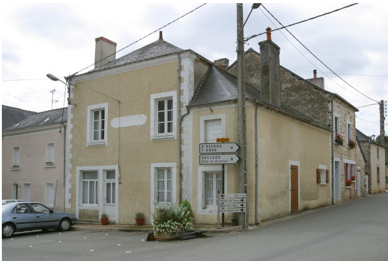
Façade sur la place et élévation ouest sur la route de Saint-Pierre.
