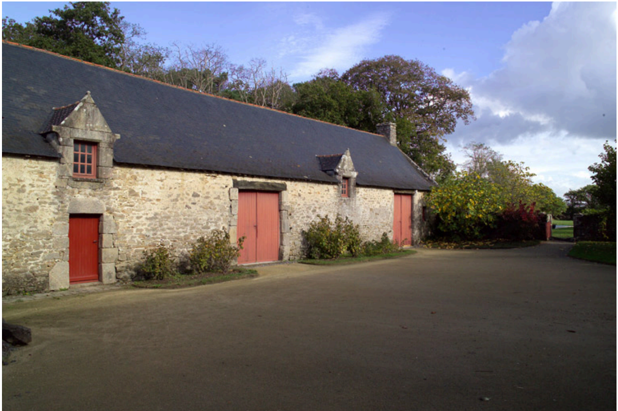
Élévation droite du second corps de communs, partie est.
