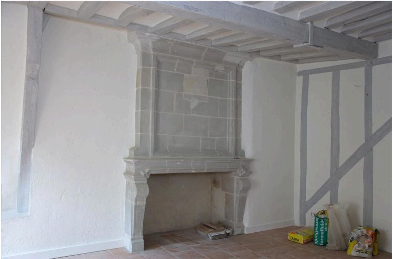
1er étage de comble, pièce antérieure, mur latéral gauche portant la cheminée ; à droite, cloison en pan de bois entre les pièces antérieure et postérieure.
