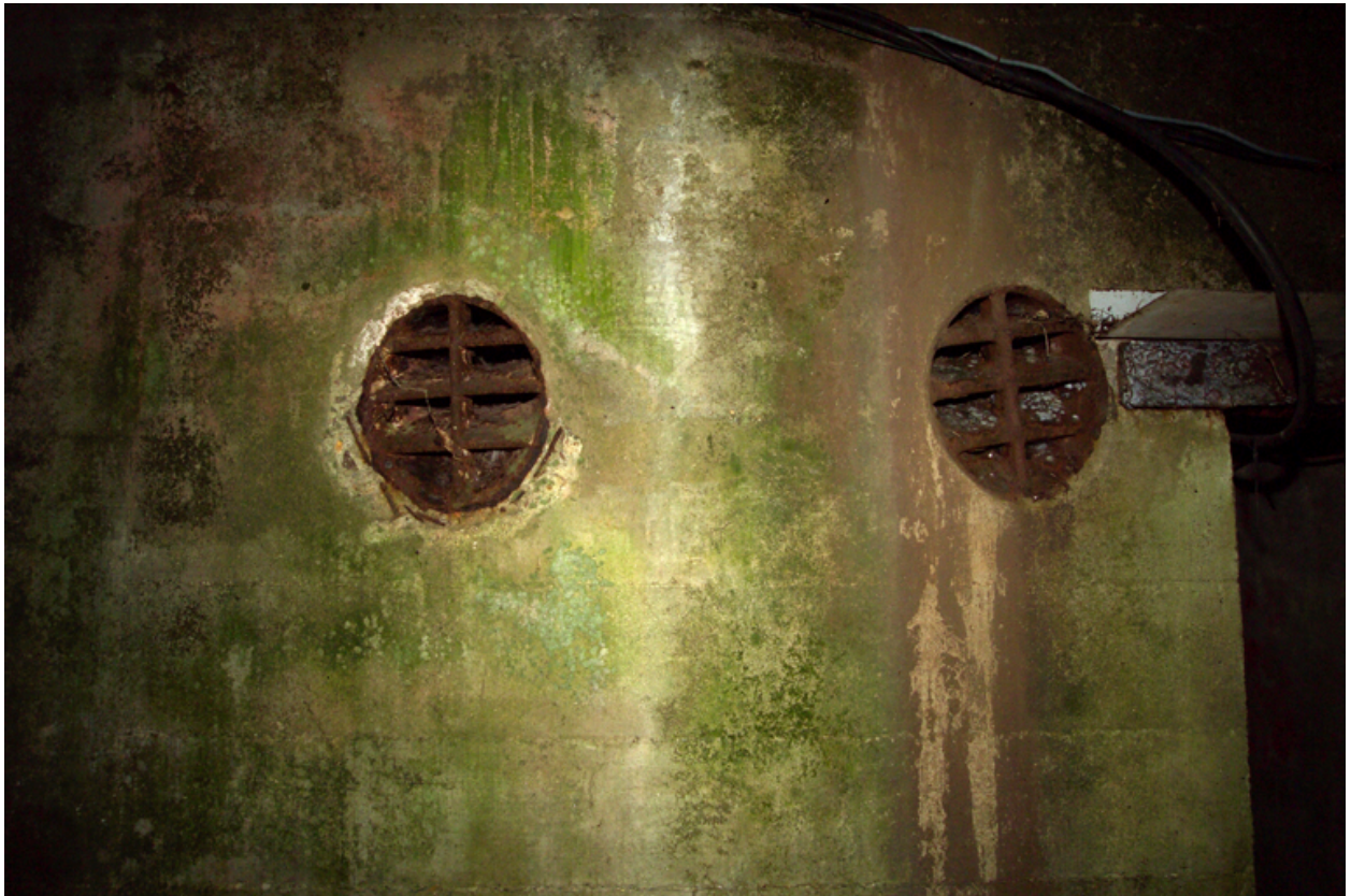
Détail des grilles d'aération.
