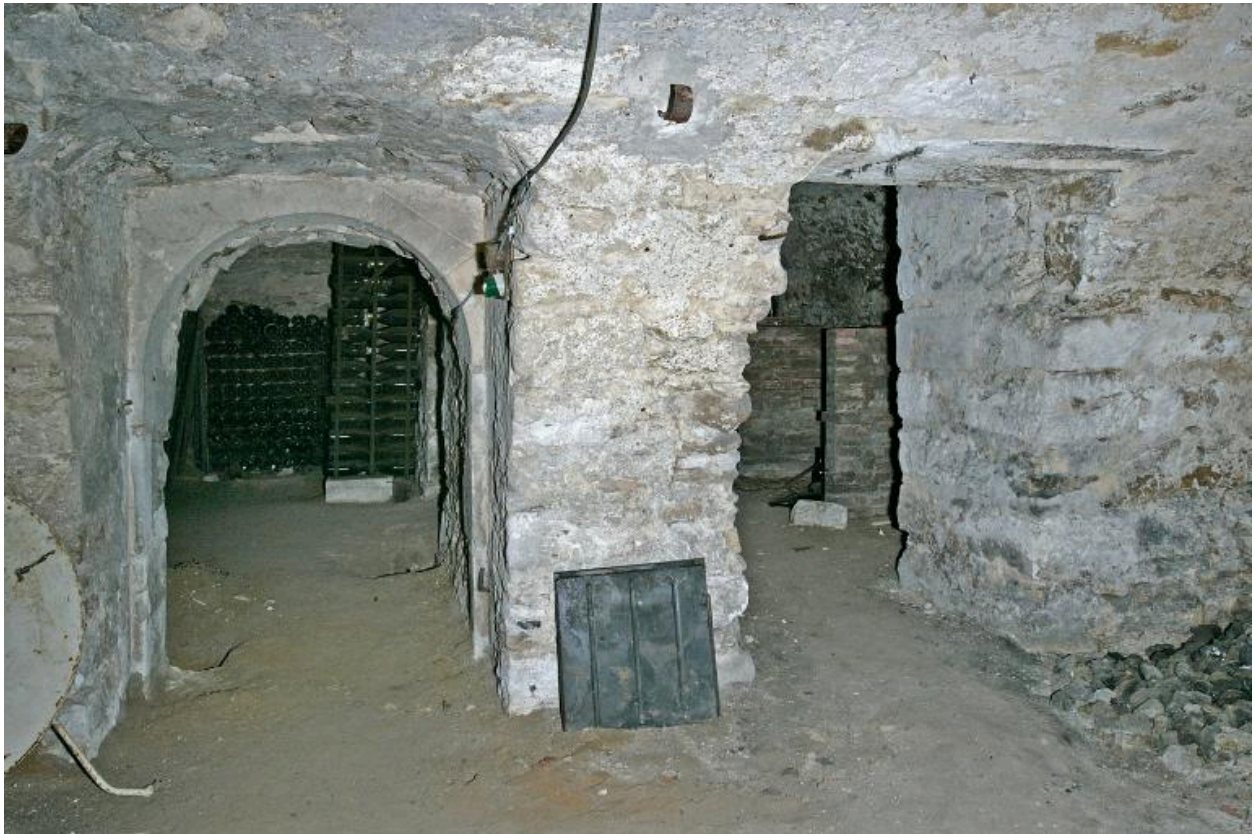
Le pavillon, sous-sol, 2007.
