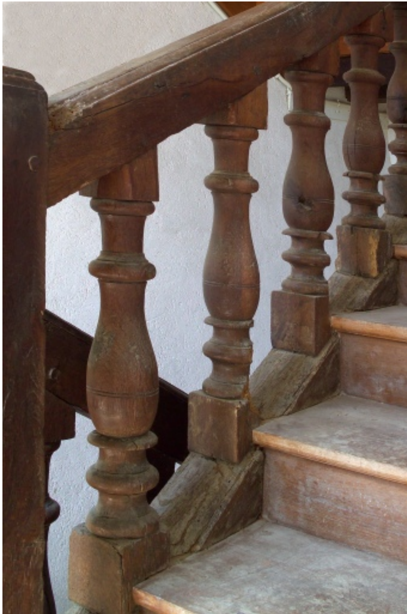
Détail des balustres de l'escalier.
