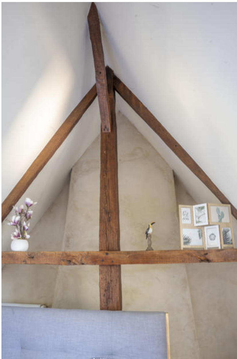
Une ferme de la charpente.
