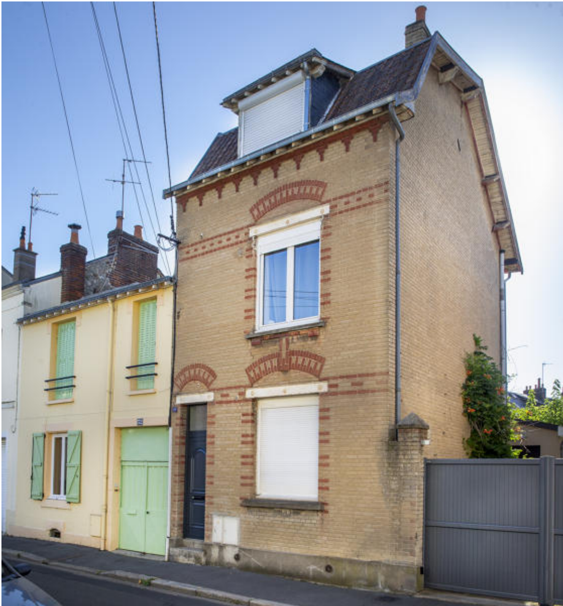
Vue d'une maison en parement brique rue Lafayette.
