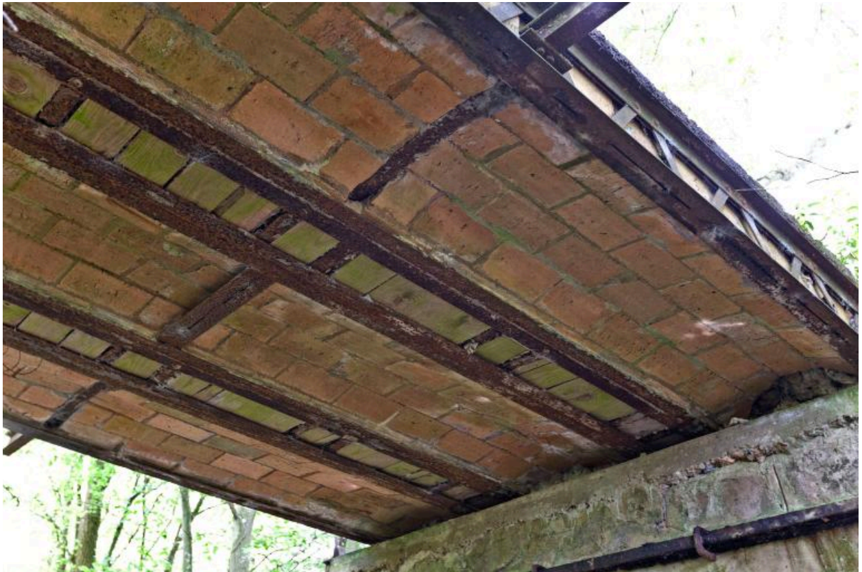
Détail du tablier
