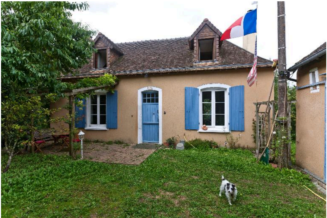
Elévation antérieure de la maison.
