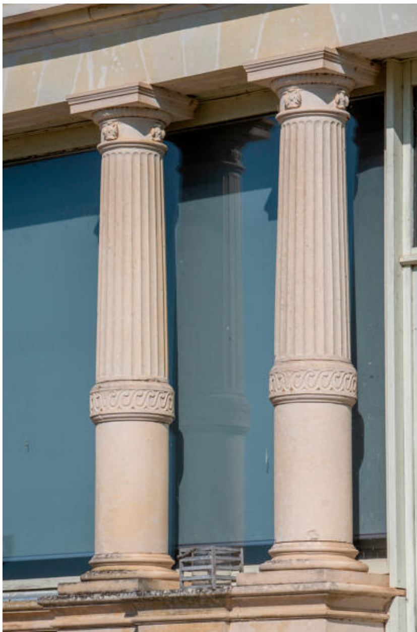
La galerie, détail des colonnes.
