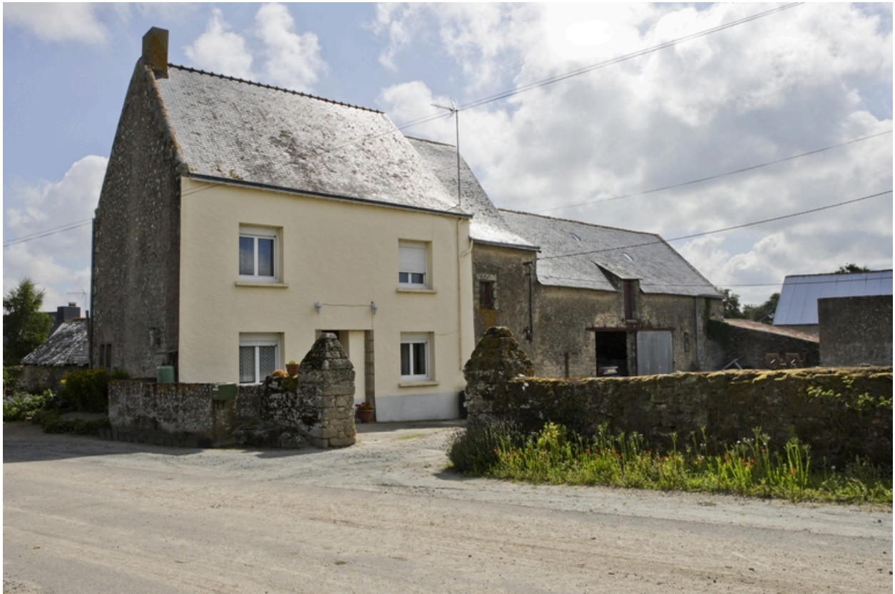
Vue du manoir depuis le sud-ouest.
