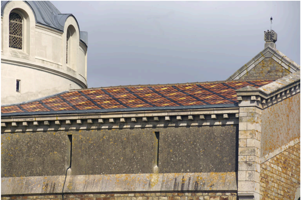
La couverture du bras occidental du transept, détail.
