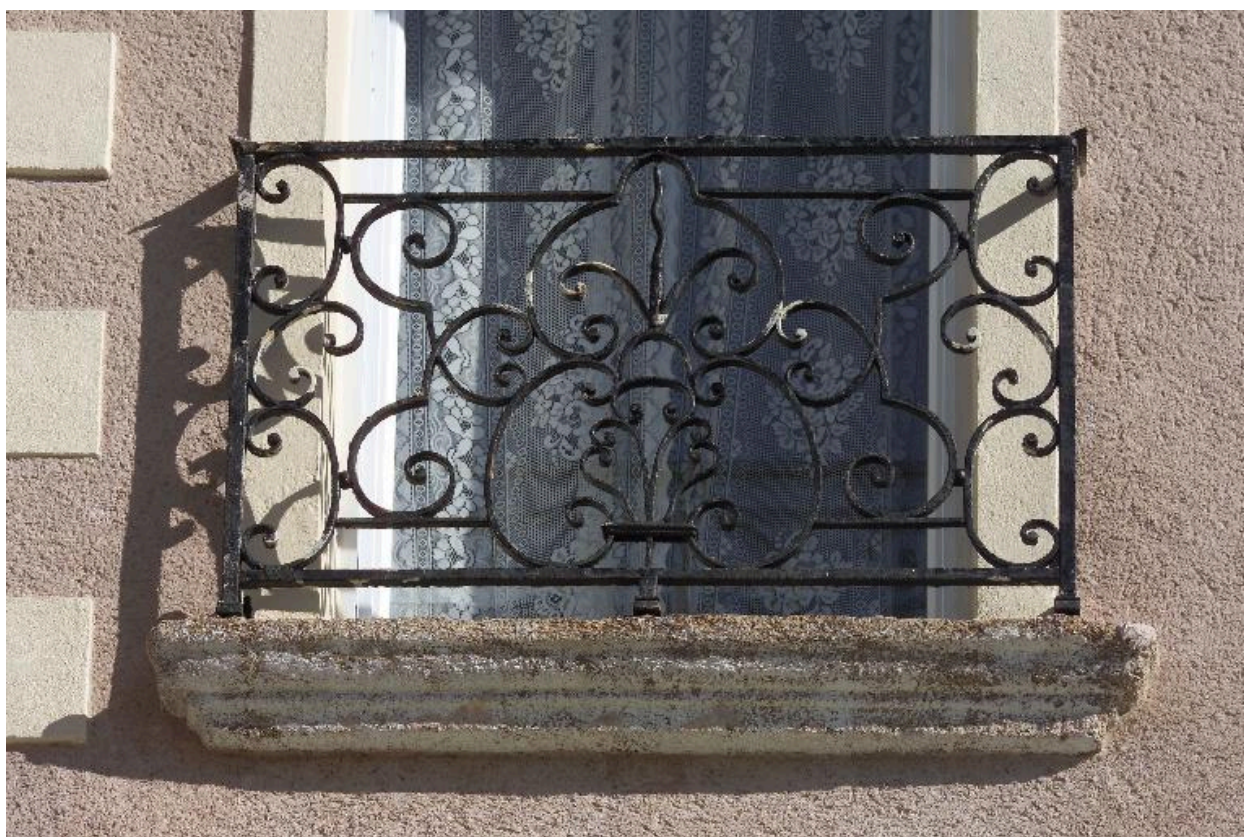
La façade n° 68 rue du Général-De-Gaulle, détail du balcon.
