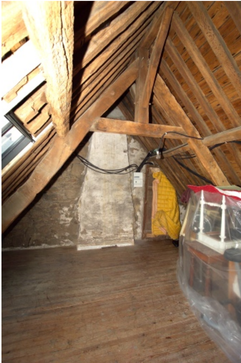
Charpente de la partie sud, vue vers le Nord.
