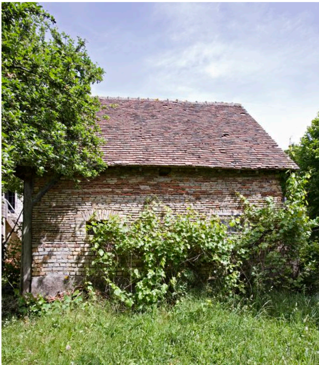
Elevation postérieure de la remise
