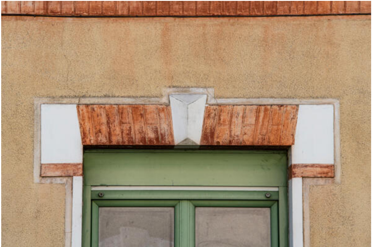
Vue d'un linteau imitation brique en façade d'une maison signée Levesque avenue Rubillard.
