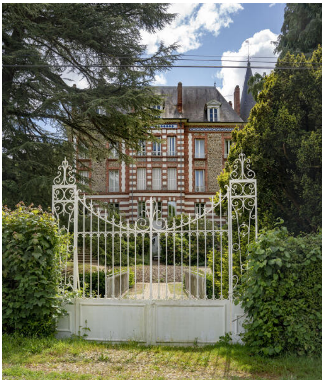
L'élévation ouest, vers la Mayenne, et le portail sur le chemin de halage.
