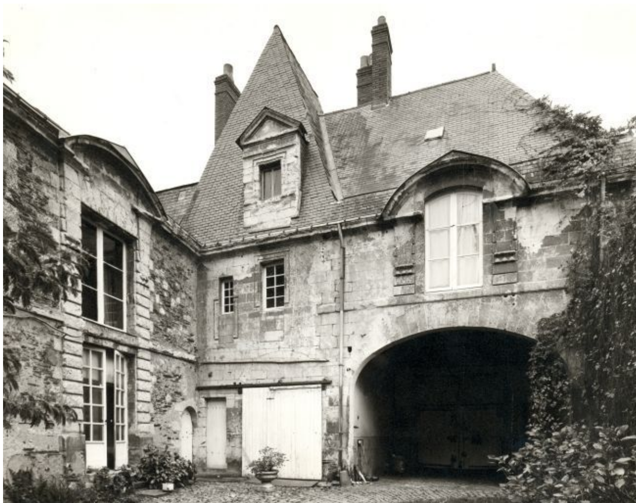
Corps sur rue, façade postérieure sur cour.
