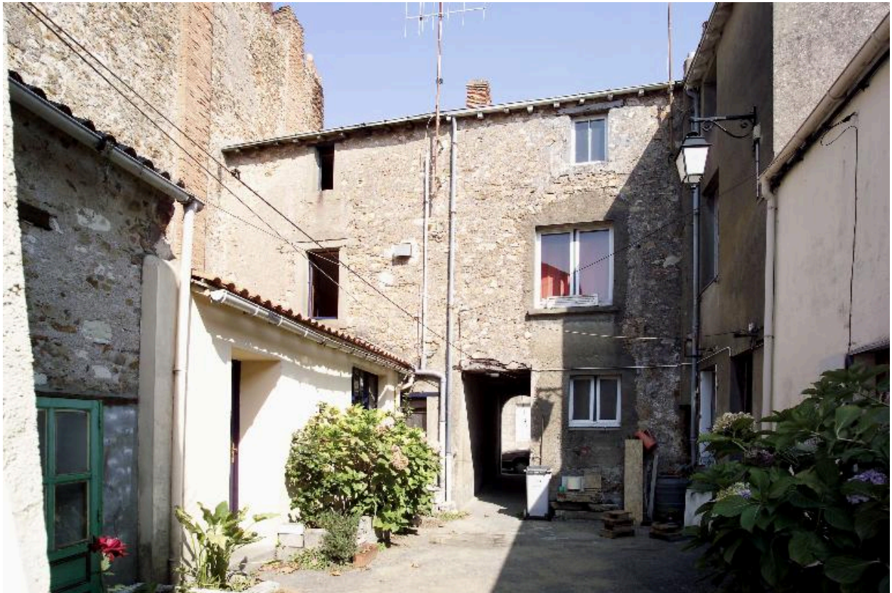
La façade postérieure des maisons n° 19 et n° 21 rue du Faisan vue depuis la cour.
