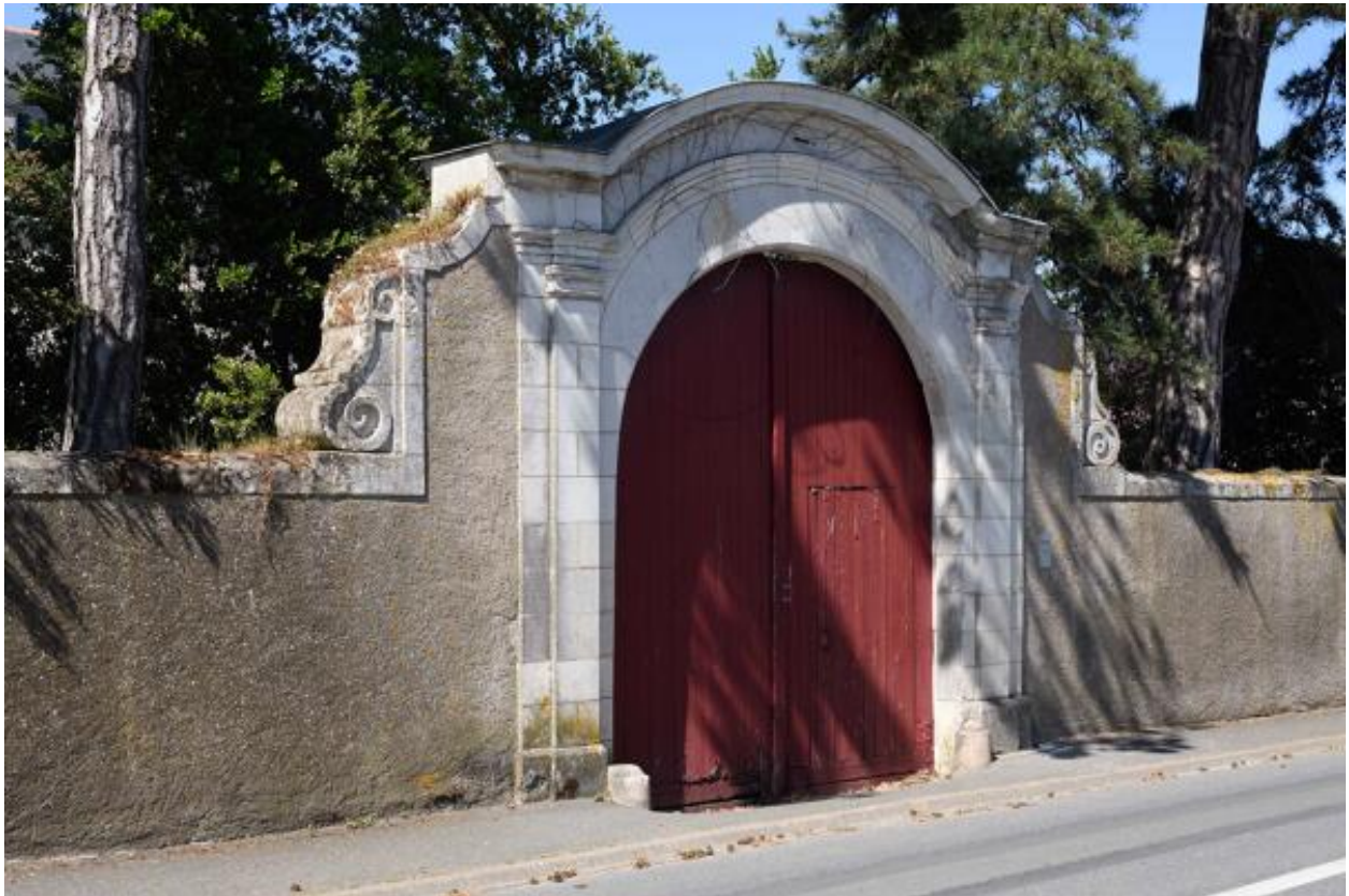
Vue du portail d'entrée depuis la rue.
