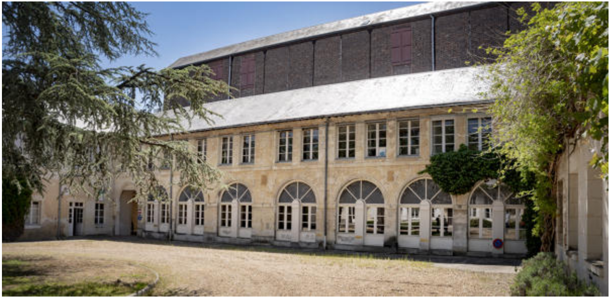
Anciens magasins et écuries A3 de l'usine de papeterie.
