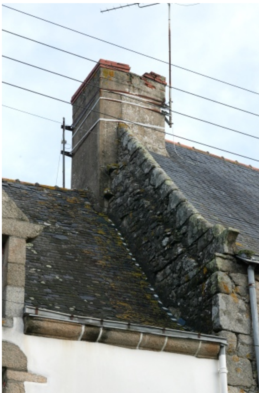
Détail du pignon ouest.
