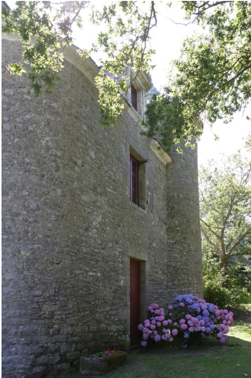
Vue du mur pignon nord depuis l'est.
