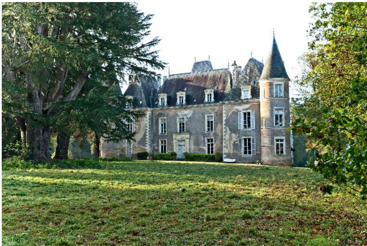
Le château vu depuis le nord-est : l'élévation antérieure.
