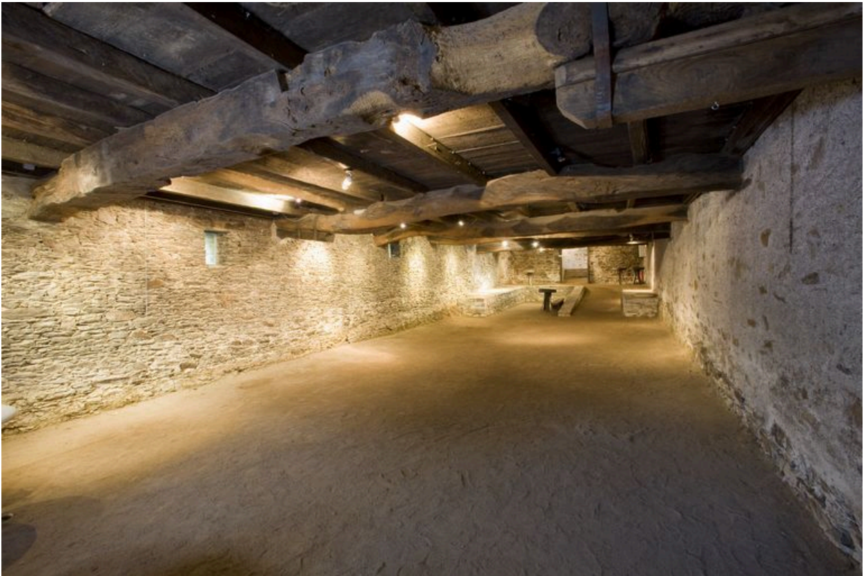
La cave : la poutraison de la partie ancienne.
