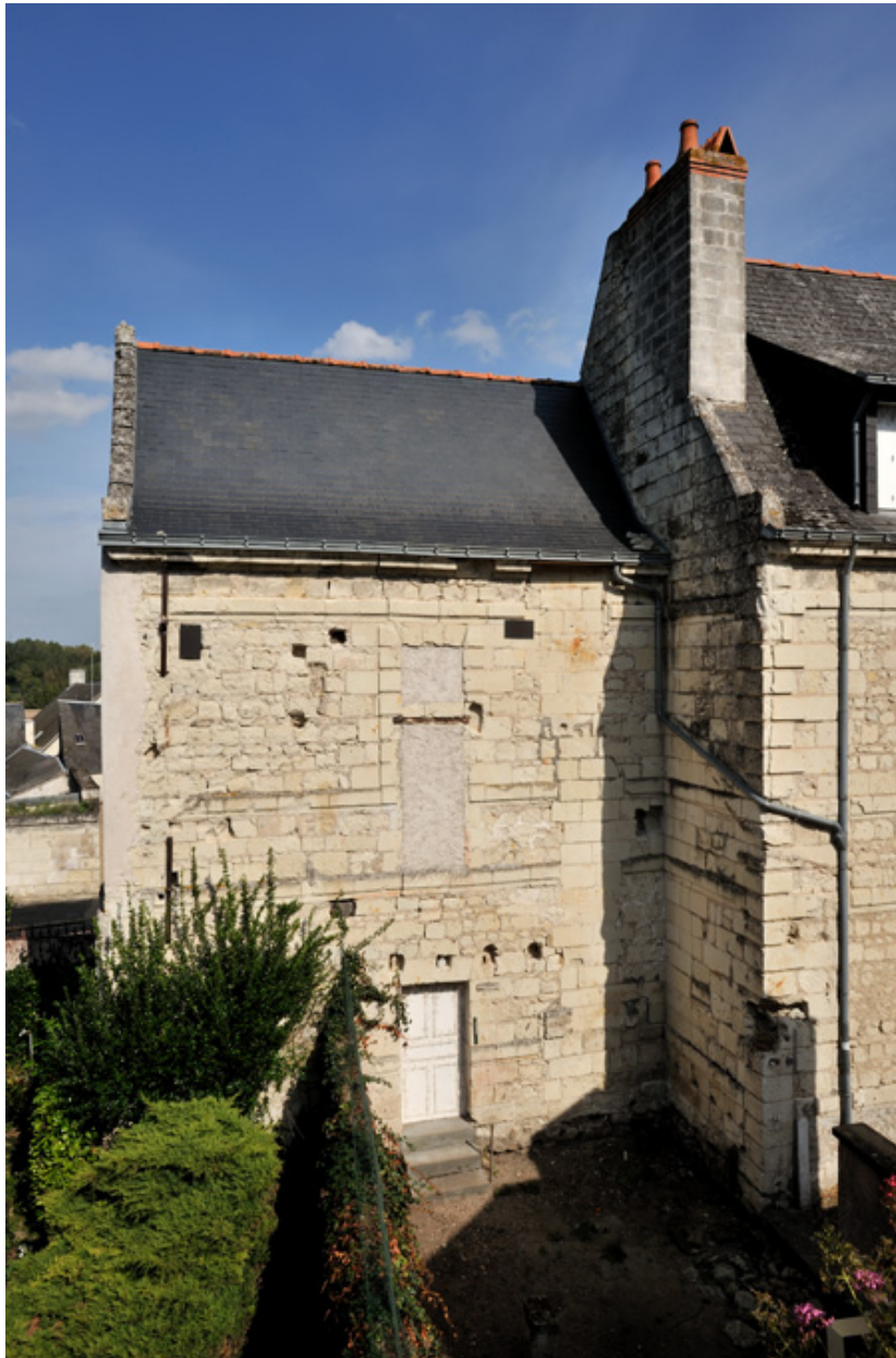
Façade postérieure de la travée ouest.
