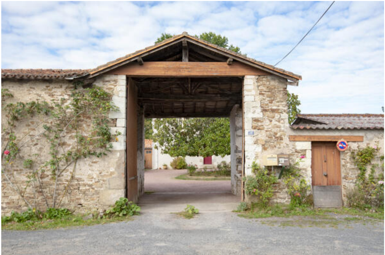
Porte cochère, depuis la route de la Haye-Fouassière.
