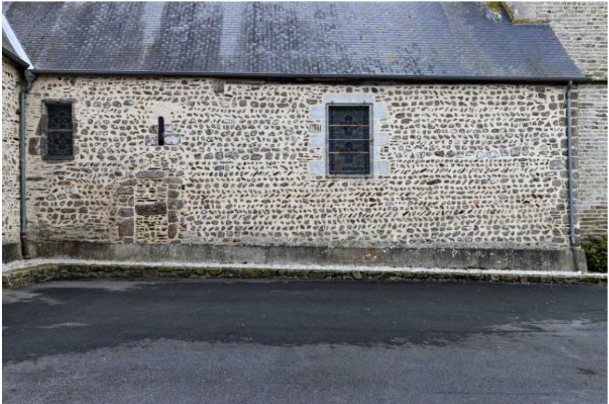
Bas-côté nord de l'église Saint-Martin de Thuboeuf.
