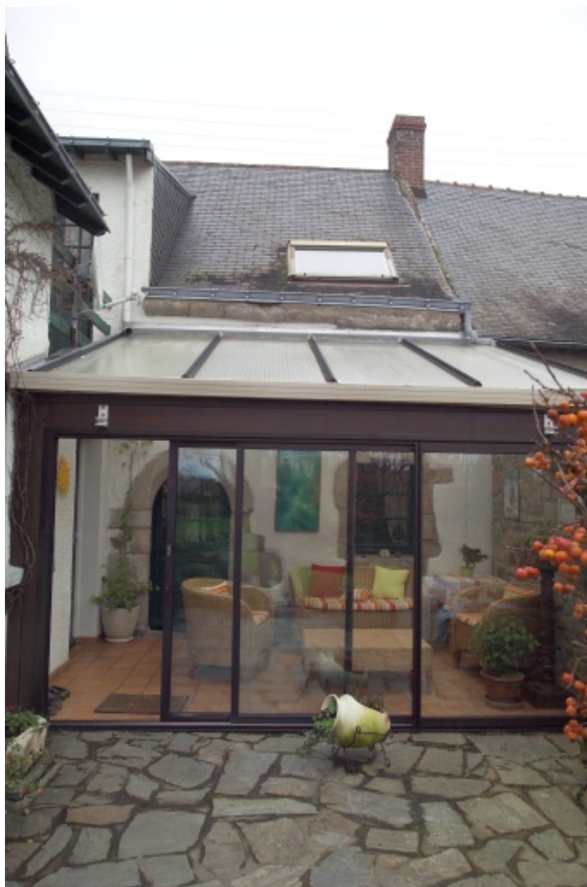
Vue de la façade postérieure.
