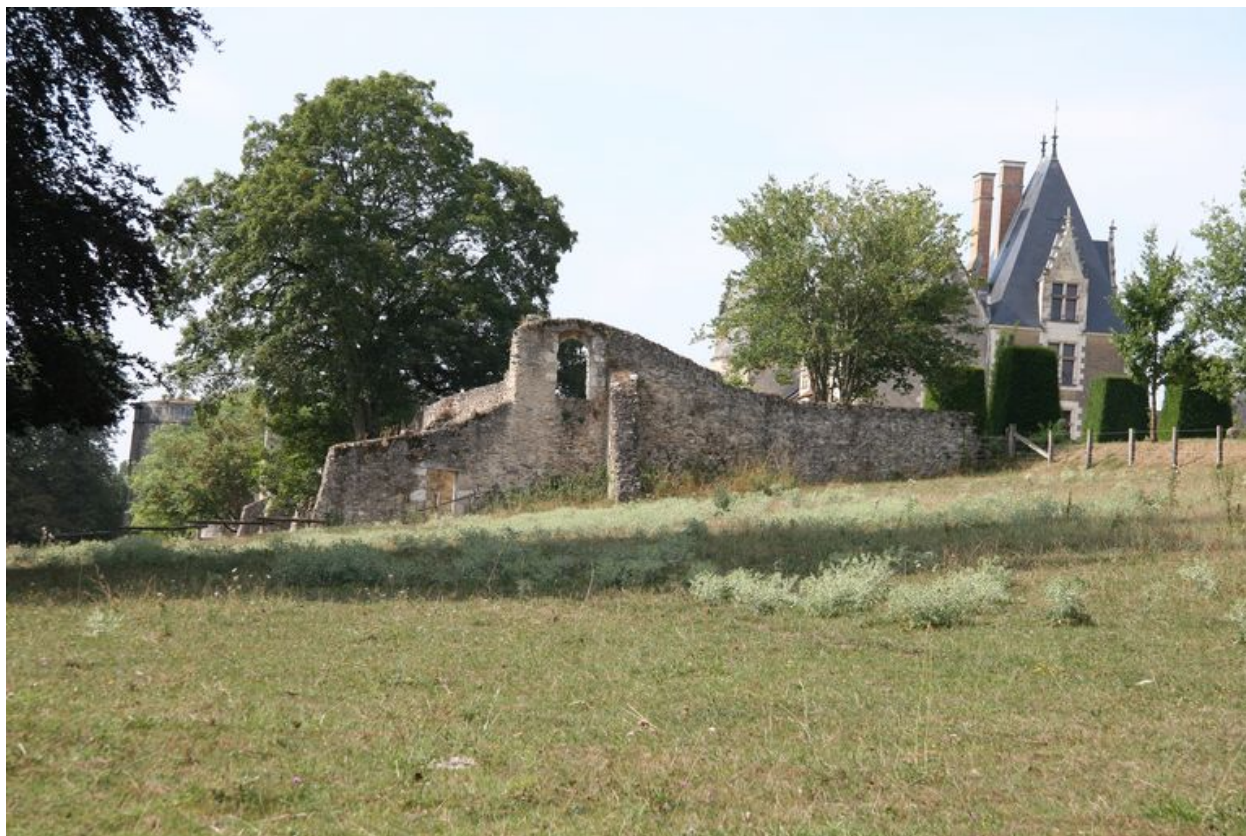
Plateforme de l'ancien château.
